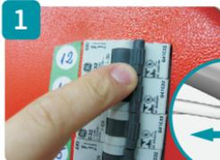
Desligue a energia na chave geral (disjuntor).
